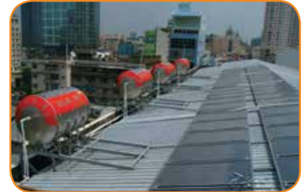
Hệ thống máy nước nóng năng lượng mặt trời Khách sạn Majestic, Tp. HCM (Nguồn: en.bk-idse.com)
