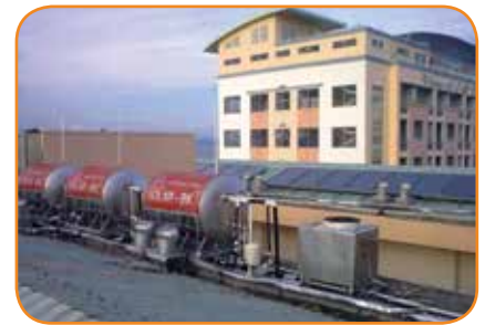
Hệ thống máy nước nóng năng lượng mặt trời Khách sạn Cap Saint Jacques - Vũng Tàu (Nguồn: en.bk-idse.com)
