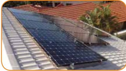
Tấm năng lượng mặt trời cung cấp điện (Nguồn: BK-IDSE Co 2012)
