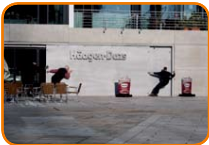
Cửa chống lụt đóng và mở cửa chống lụt tại tầng trệt của thành phố Hafen Hamburg
