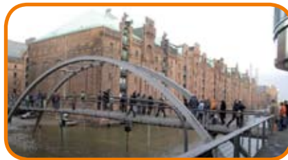
Các lối thoát khẩn cấp cố định
