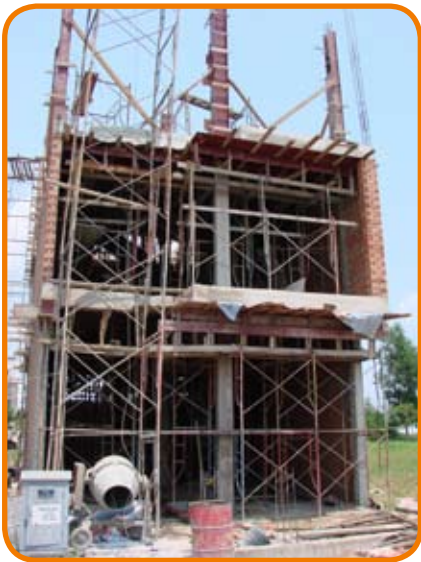
Nhà phố đang được xây dựng, gạch nhẹ được sử dụng để cách nhiệt (Nguồn: Waibel 2010)
