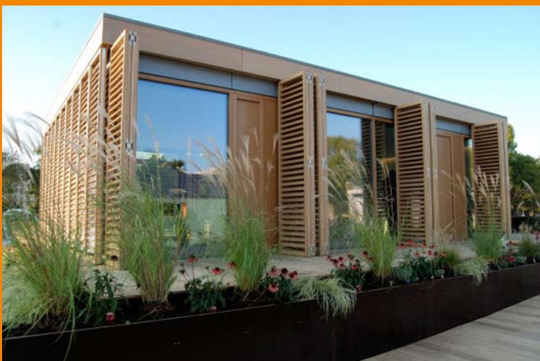
Ngôi nhà mặt trời được che chắn nắng hoàn toàn tại TU Darmstadt / Germany (Nguồn: Hegger, 2007)
