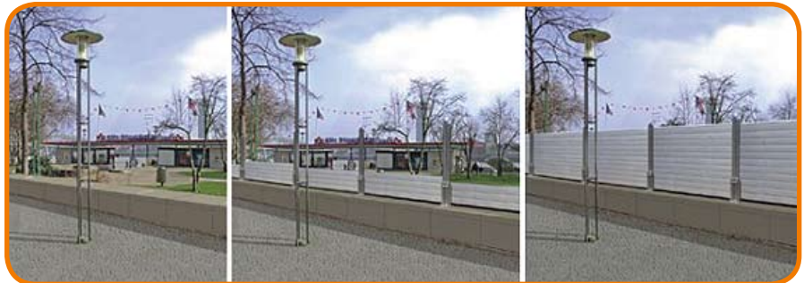
Tường chống lụt di động được làm bằng hệ thống dầm ngăn nước cho các công trình công cộng (Nguồn: IBS 2010)
