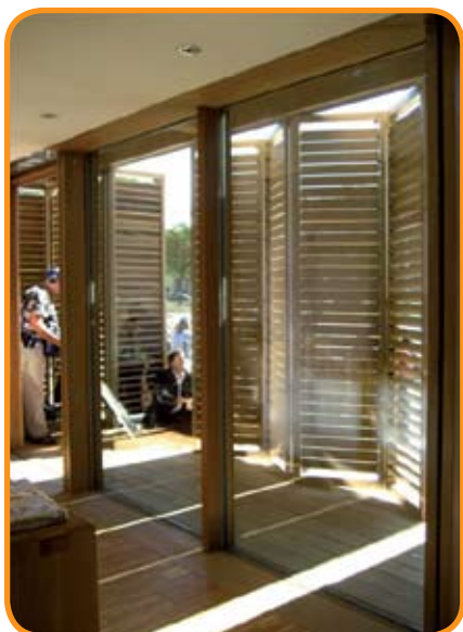
Vùng giảm nhiệt phía bên trong bề mặt công trình (Nguồn: Hegger, TU Darmstadt 2007)
