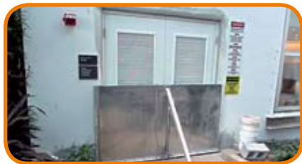
Bịt kín các chỗ hở cố định hoặc di động (Nguồn: ICPR 2002/www.floodpanel.com)
